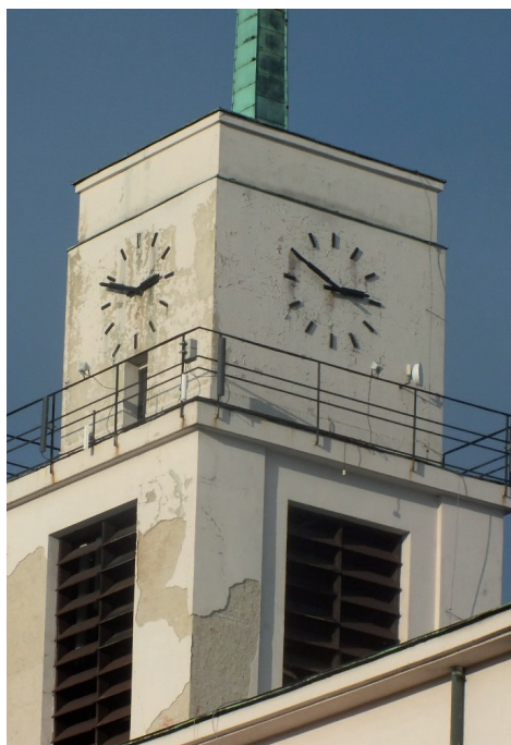
Věž před opravou a nyní
